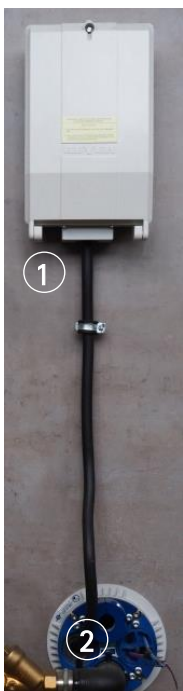
Abb. 3: Stromhausanschluss
