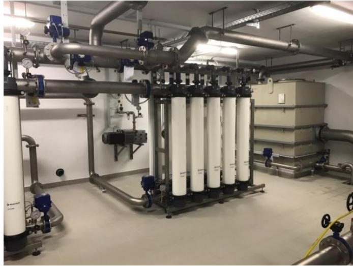
Beispiel UF-Anlage (Foto: Strecker Wassertechnik GmbH)
