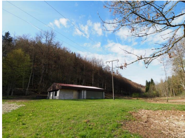
Wasserwerk Tiefental: Außenansicht (Foto: swt)
